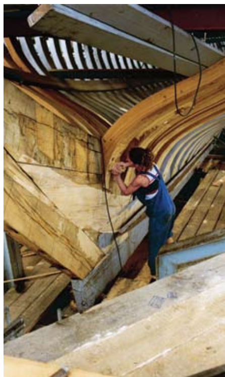
Arbeit an den Spanten
