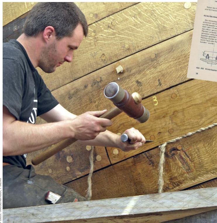
Fachgerechtes Kalfatern mit Baumwollfaden eines karweel beplankten Arbeitsboots und die alte Anleitung für die Bearbeitung von Klinkerbooten.
